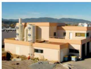
Station d'épuration du Reyran
