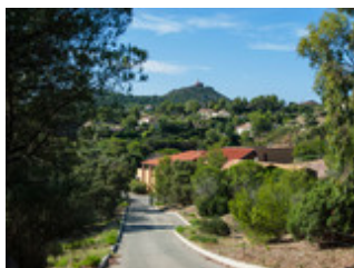
Station d'épuration d'Agay
