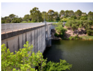
Barrage du Saint-Esprit
